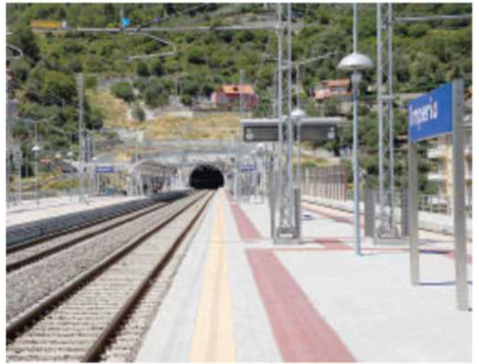
La nuova stazione di Imperia, sull'Argine Destro
